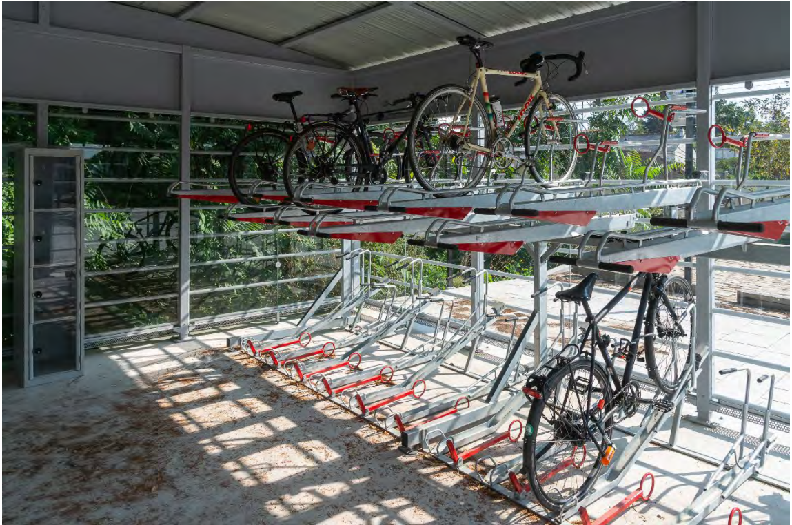
Emplacements de stationnement à étages à la gare de Coueron © Olivier Guitard / FUB
