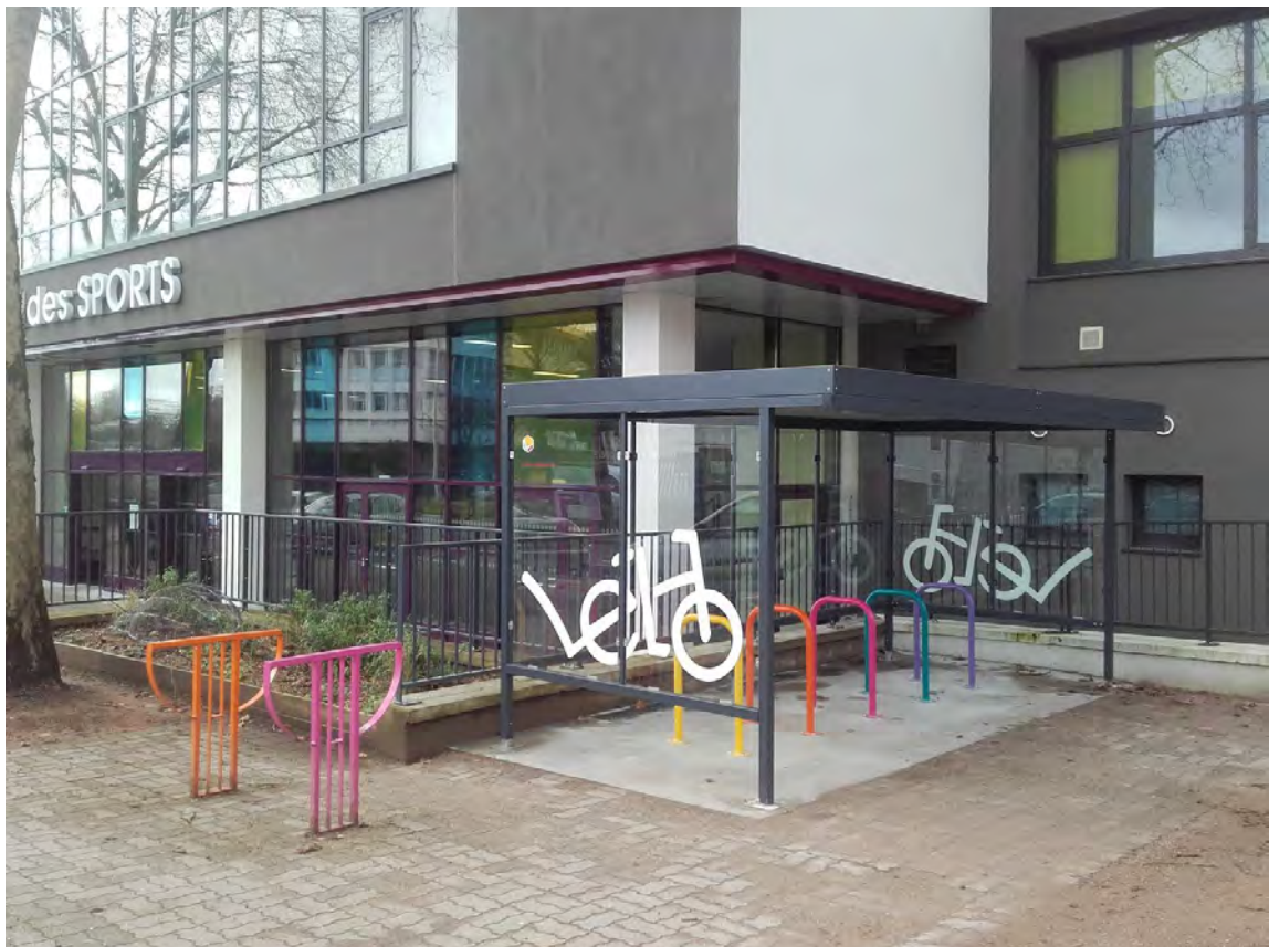
Abri vélo extérieur accessible au public de la Maison des Sports de Nevers © Nevers Agglomération / CVTCM
