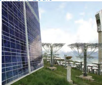
Der erste Solarofen mit zweifacher Reflexion der Welt wurde ab 1947 von Professor Félix Trombe in Mont-Louis errichtet. Er regte die wissenschaftliche Forschung an und ermöglichte eine industrielle Anwendung bei sehr hohen Temperaturen zwischen 1000 °C und 3000 °C. Er diente als Prototyp für die Konstruktion des großen Solarschmelzofens von Odeillo und als Referenz für alle (rund zehn) Sonnenöfen, die seitdem überall in der Welt gebaut wurden.
