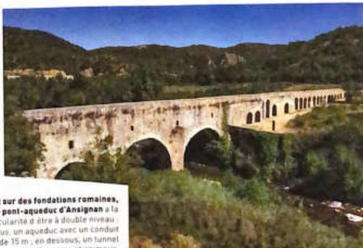
Construit sur des fondations romaines, le pont-aqueduc d'Ansignan a la particularité d'être à double niveau : au-dessus, un aqueduc avec un conduit d'eau de 15 m ; en dessous, un tunnel pour humains et animaux.
